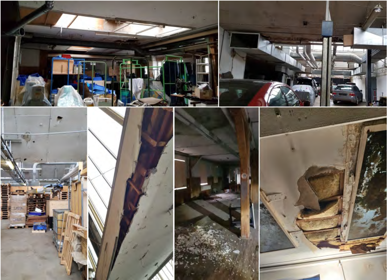
Abb. 11: untere Stockwerke des Gebäudekomplexes
