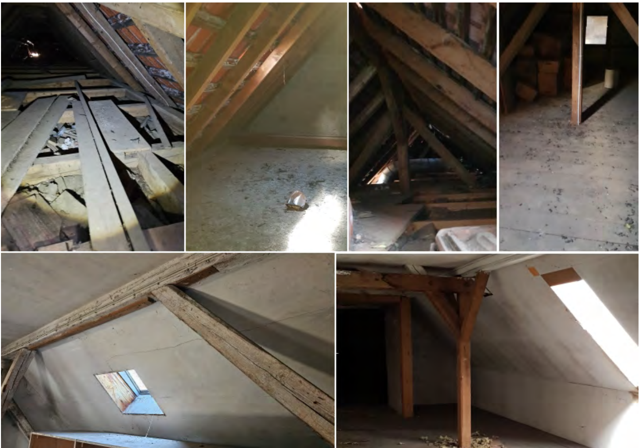
Abb. 12: Aufnahmen des oberen Stockwerks sowie des Dachbodens im Mai 2024
