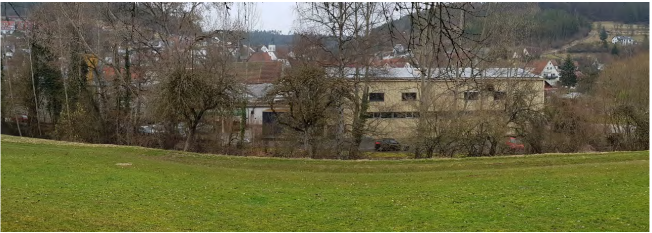
Abb. 5: Blick auf den Gebäudekomplex mit vorgelagerter, von Gehölzen bestandene Waldach aus westlicher Richtung
