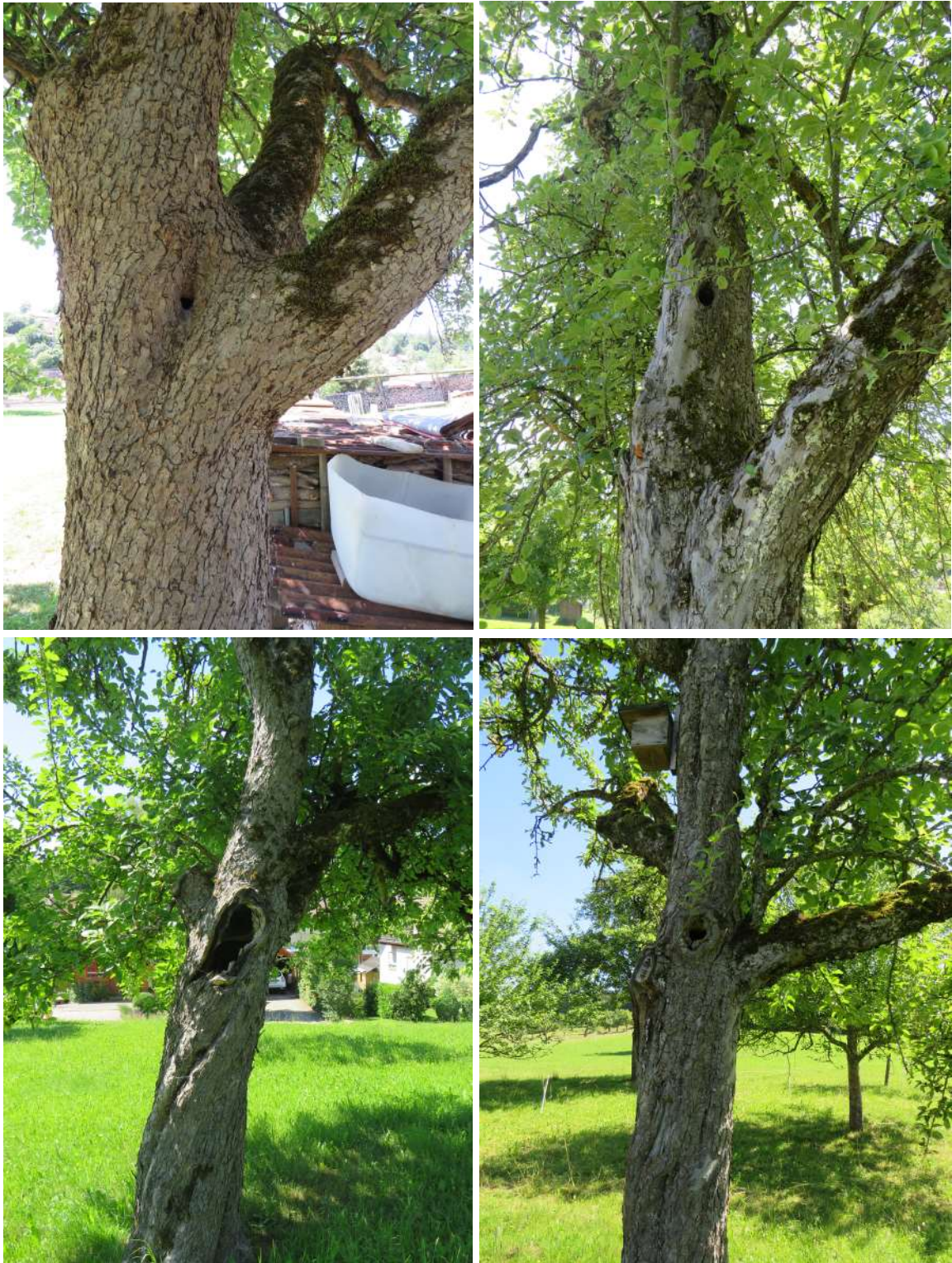
Abbildungen 11 - 14 Höhlen- und Spaltenbäume im Plangebiet
