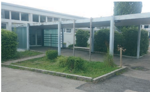
Eingang Süd und Pflanzfläche
